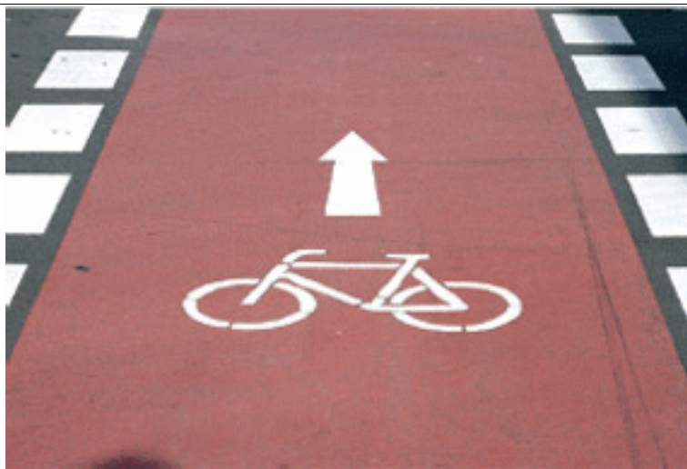
Abbildung 16: Farbige Fahrbahnmarkierungen zur Abgrenzung von Radwegen
