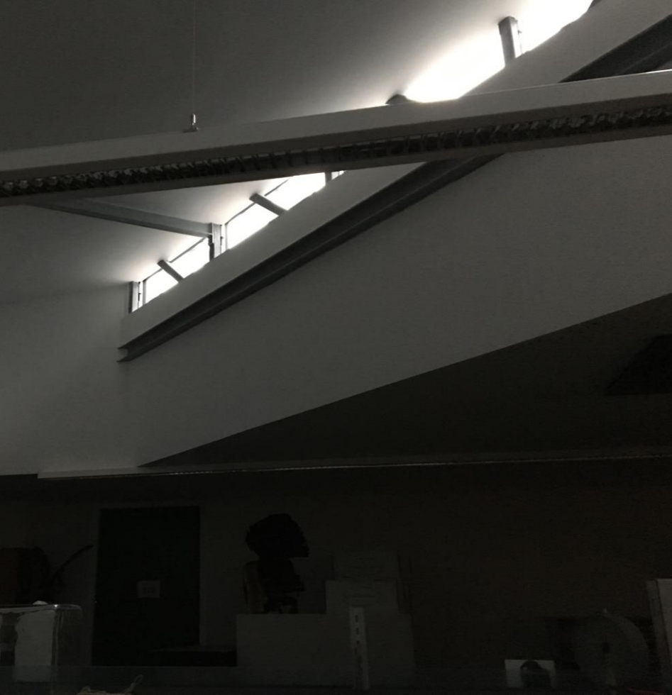
Oberlicht Vorbereitung NwT-Bereich – nachträglicher Einbau der Dämmung
