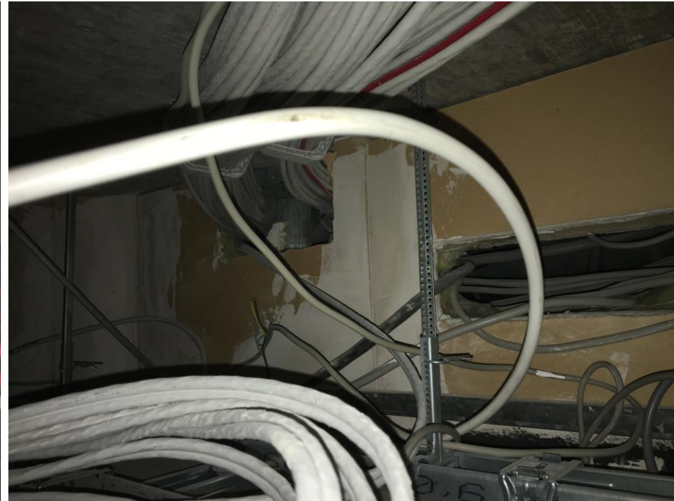
Zwischendeckenbereich Technikraum 236 / F90-Decke im Flur 265
