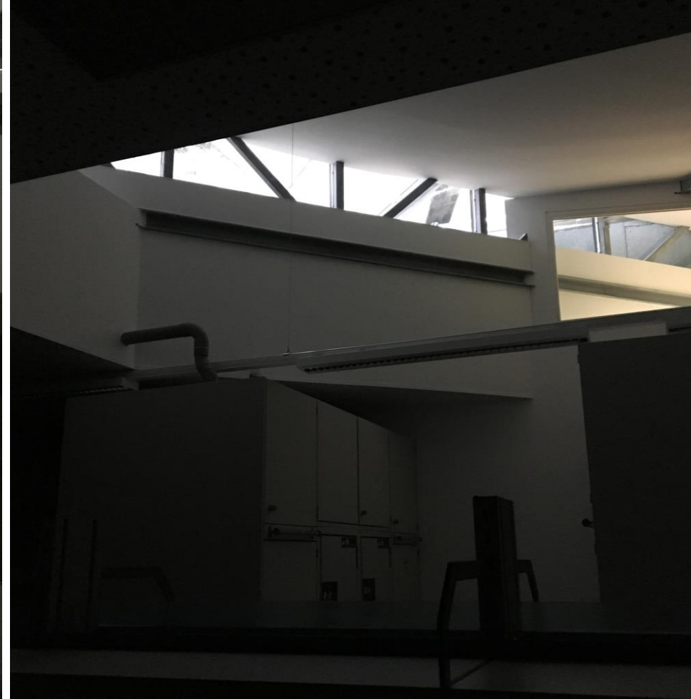
Oberlicht Vorbereitung NwT-Bereich – nachträglicher Einbau der Dämmung
