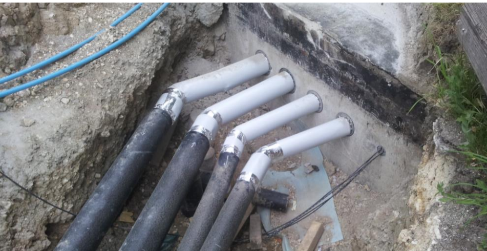
Anschluss Erdsonden – Durchdringung in den Verbindungsgang
