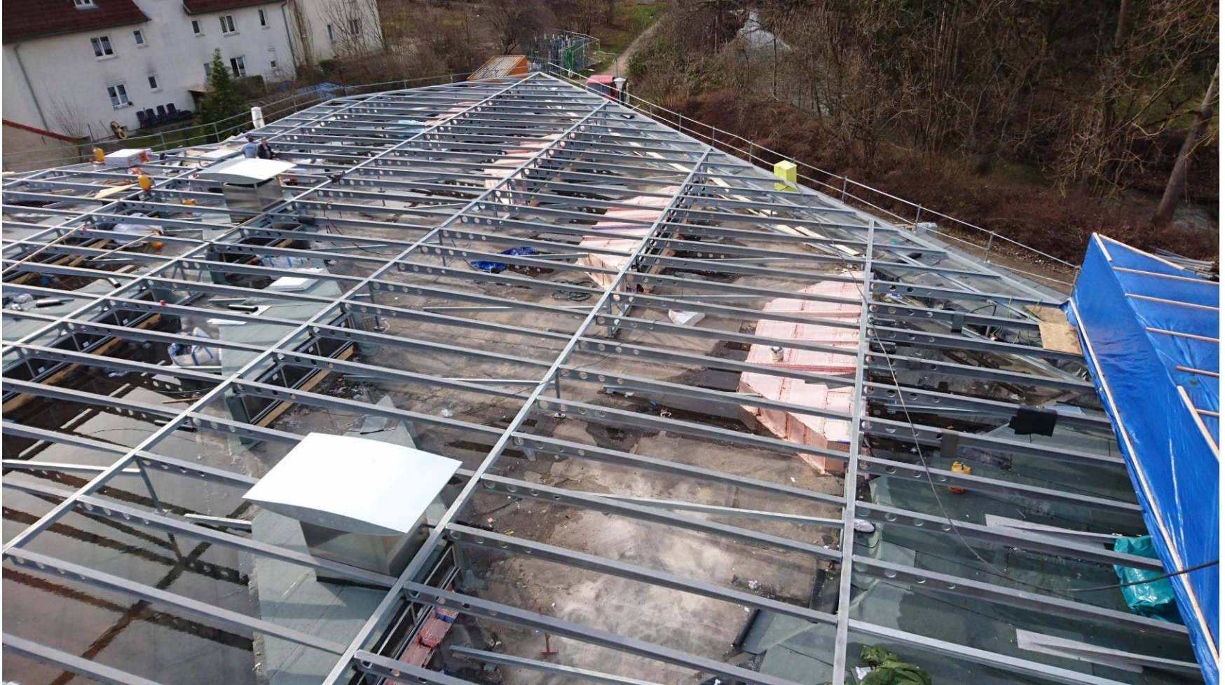
Stahlkonstruktion – nachträglich gedämmter Dachaufbau (02/2016)
