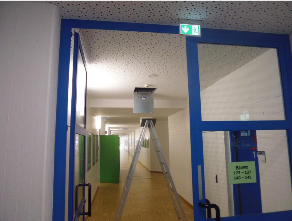
Brandabschnitt Achse 8 – EG, Zugang NWT-Bereich, Flur 113
