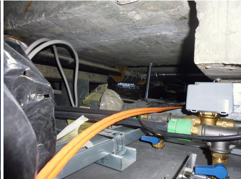
Brandabschnitt Achse 8 – EG, Zugang NWT-Bereich, Flur 113
