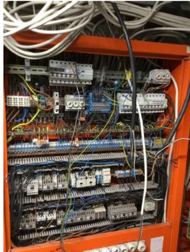
Alte Unterverteiler
