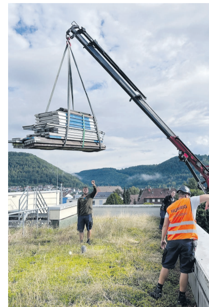
Der Autokran hievt das Gerüst aufs Dach vom HfWU-Gebäude.
