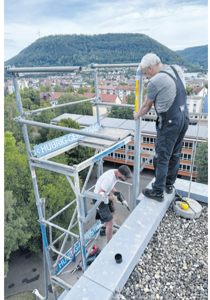
Die Bauhof-Mitarbeiter montieren einen Antennenmasten am HfWU-Gebäude (links). Oberbürgermeister Frank Dehmer, IT-Experte Uwe Ritter und Bauhof-Chef Dieter Seng sowie drei Bauhof-Mitarbeiter auf dem Dach der Hochschule (rechts).
