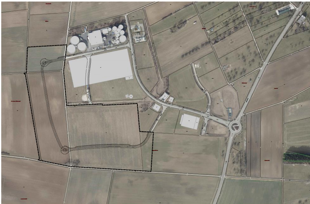
Abb 1: Geltungsbereich Bebauungsplan „Erweiterung Gewerbepark Schwäbische Alb“ (Quelle: Landesamt für Geoinformation und Landentwicklung Baden-Württemberg)
