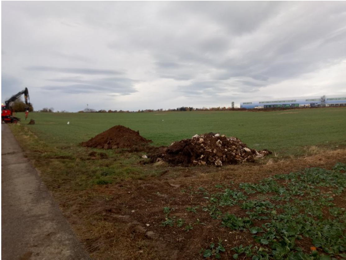
Bild: Bauareal am 03.11.2021 (Blickrichtung Westen)
