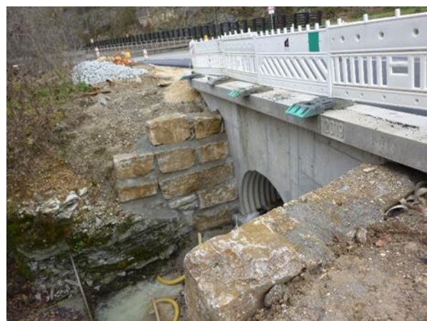
Verbreiterung der Flutgrabenbrücke
